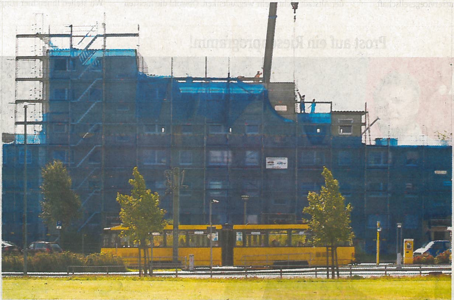
Derzeit hat an der Schlesischen Straße in Königshufen beinahe jedes Haus eine andere Höhe. Ende nächster Woche aber soll der Geschossrückbau an dieser Stelle abgeschlossen werden. Dann sind nur noch drei Stockwerke übrig.
